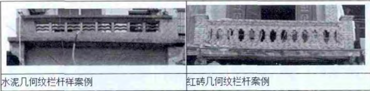
图 3- 相同样式不同材质的栏杆案例对比 (笔者自绘)
