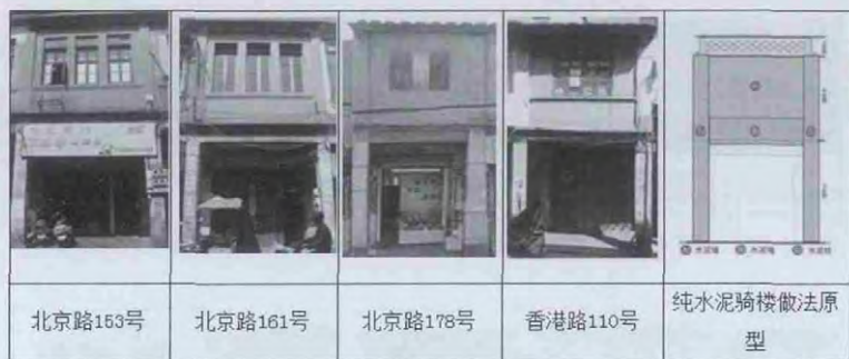
图 8- 纯水泥骑楼样式案例与做法示意 (笔者自绘)
