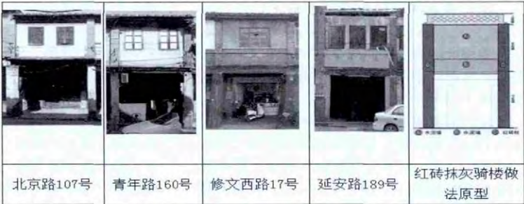
图 7- 红砖抹灰骑楼样式案例与做法示意 (笔者自绘)
