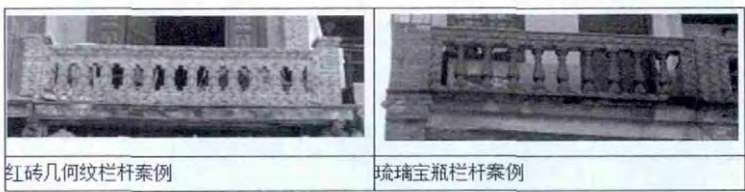
图 4- 不同样式相同材质的栏杆案例对比 (笔者自绘)
