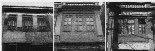
图8 木板外墙骑楼(左)→“木梁砖拱”骑楼(中)→红砖骑楼的发展演变(右)
