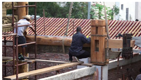
图 15: 步通出上榀尾榫头安装调整
