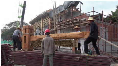
图 10: 步通出上样尾构件穿柱
