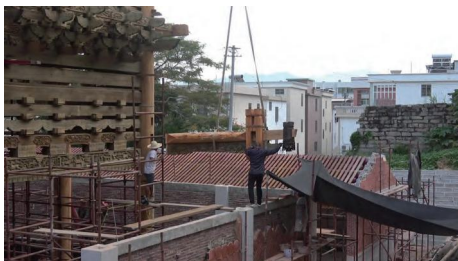
图 14: 步通出上榀尾吊装至构架
