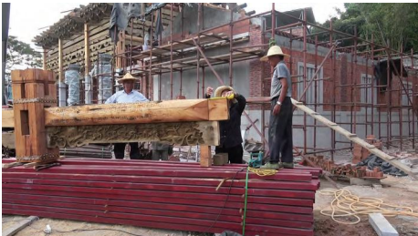
图 12: 步通出上样尾榫头尺寸标注
